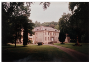
Château de Fonteneau à Nivelles.
